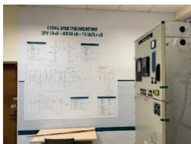
Комплектное распределительное устройство D-12P
