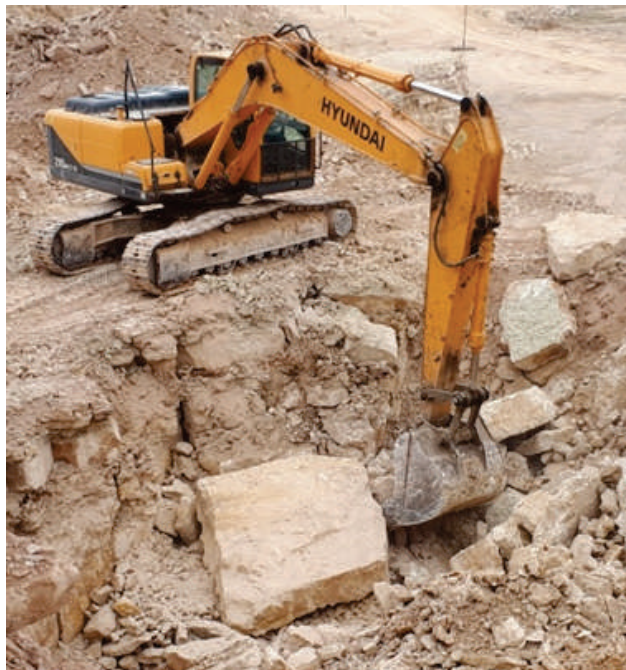
Разборка крупноблочных разностных слоев обратной гидравлической лопатой
