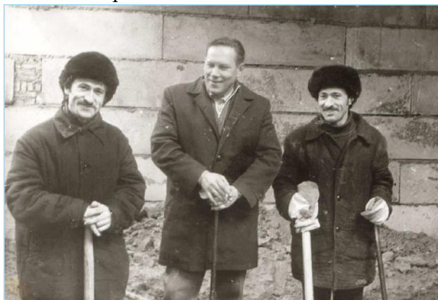
Ладыгин Е.А. на строительстве лаборатории радиационных технологий
