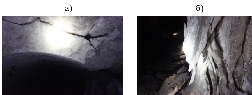
Рисунок 3.1 – Отжим массива каменной соли на контурах пересекающей МКЦ выработки (а) и МКЦ (б) на глубину до 0,5 м от обнажения с характерным образованием разрывных трещин (Соль-Илецкий рудник)
