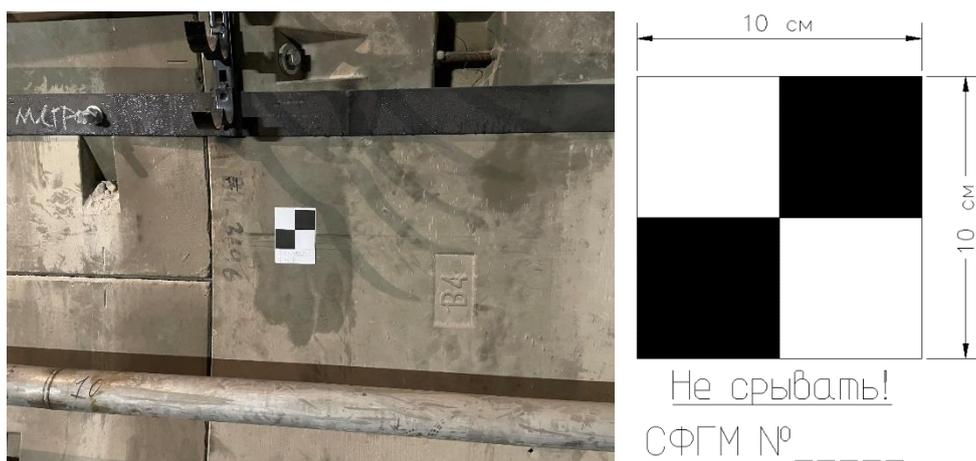
Рисунок 2.7 - Установленная СФГМ на обделке тоннеля (слева) и её габаритные размеры (справа) [45]
