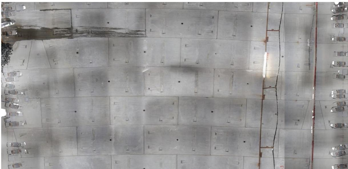
Рисунок 3.26 - ЦКТ участка перегонного тоннеля со следами водопроявлений
