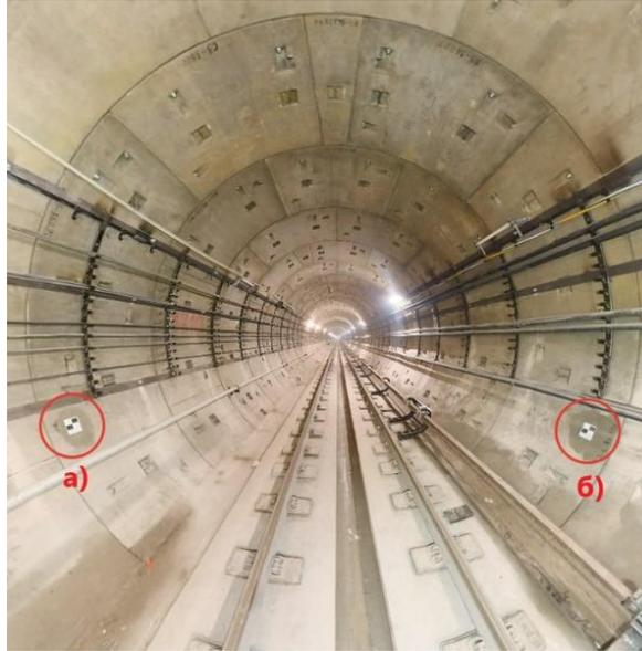
Рисунок 2.10 - Места установки СФГМ на тубинговом кольце (обведены окружностями): а) со стороны дорожки для прохода персонала; б) со стороны контактного рельса [45]
