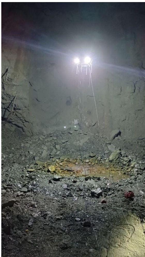
Рисунок 2.2.3 – Процесс обследования ствола с использованием видеозонда
