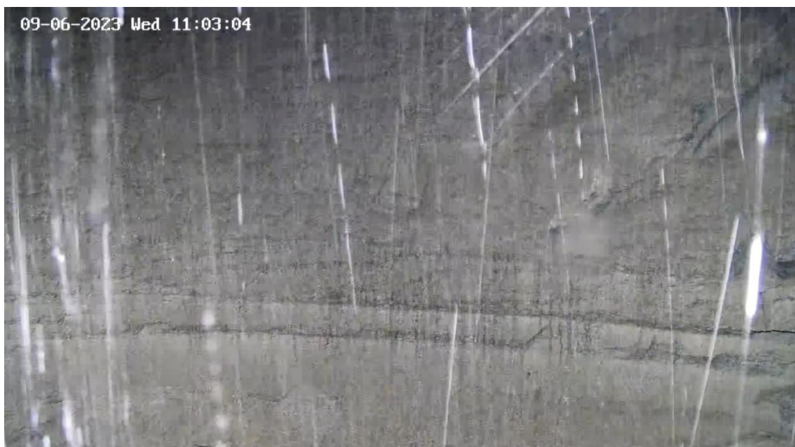
Рисунок 2.2.4 – Пример типичного состояния незакрепленной породной стенки (туф базальтового состава) незакрепленного ствола на глубине 515 м
