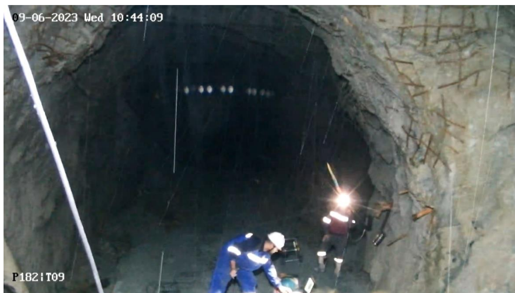
Рисунок 2.2.10 – Состояние пород в примыкающем к стволу сопряжении
