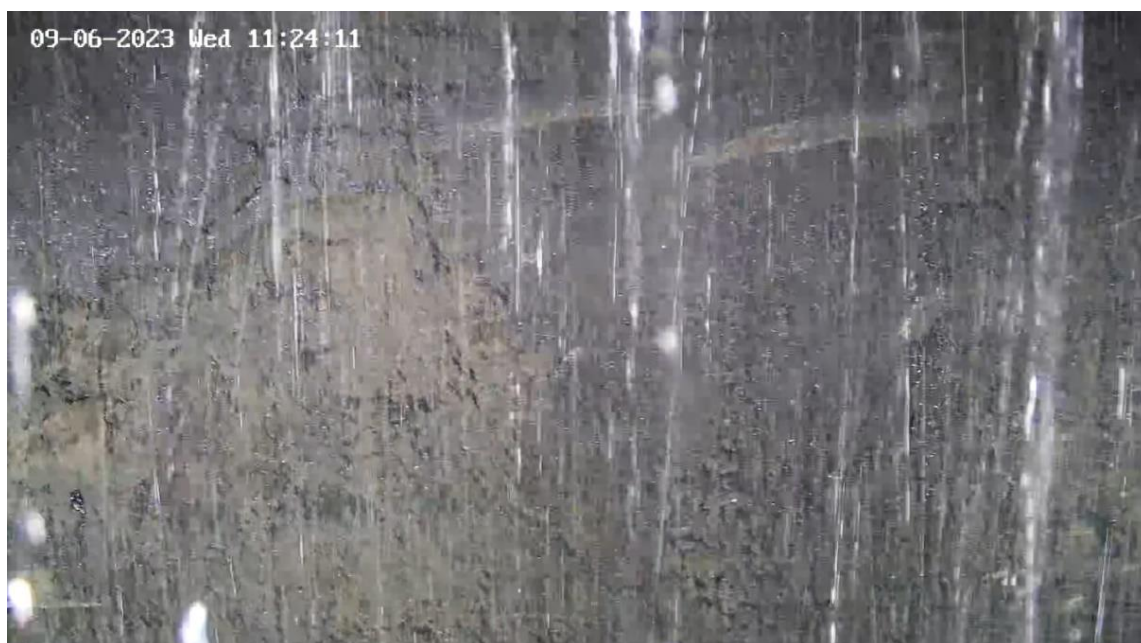
Рисунок 2.2.5 – Пример типичного состояния незакрепленной породной стенки (базальтовая толща) незакрепленного ствола на глубине 557,5 м
