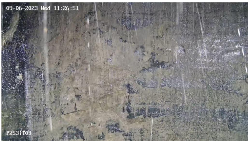
Рисунок 2.2.6 – Пример типичного состояния породной стенки (базальтовая толща) незакрепленного ствола на глубине 567 м
