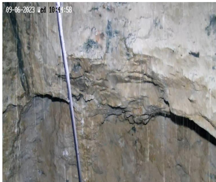
Рисунок 2.2.9 – Участок локального разрушения пород на участке примыкания ствола к буровой камере
