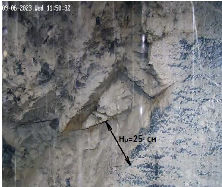
Рисунок 2.2.8 – Пример участка ствола с отслоением пород глубиной до 25 см
