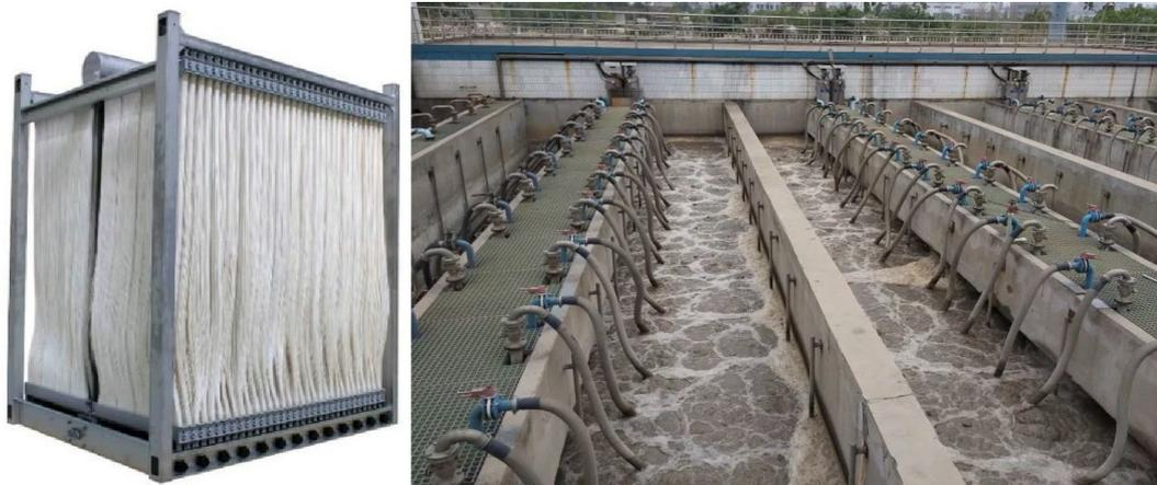
Рисунок 5.17 – Модуль погружных половолоконных мембран
